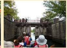
下流側の扉が開き始めた
