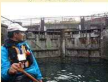
閘門上流側の扉が開まる
