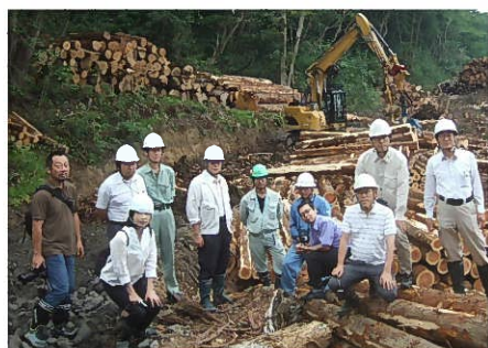
伐採現場現地見学
