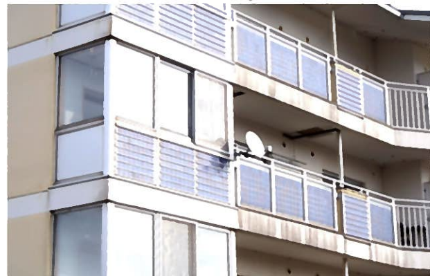
手摺に太陽光発電セルを設置した黒部市生地特定公共住宅
