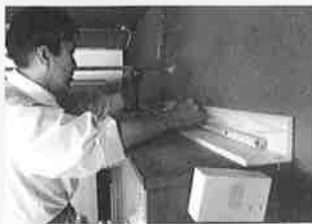
家具固定状況
