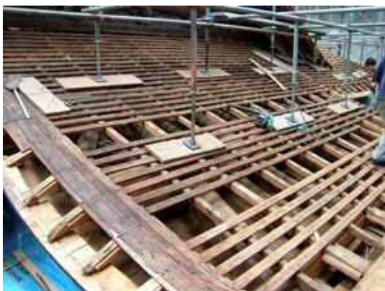
古い葺き材を取った状態。野地が見える。
