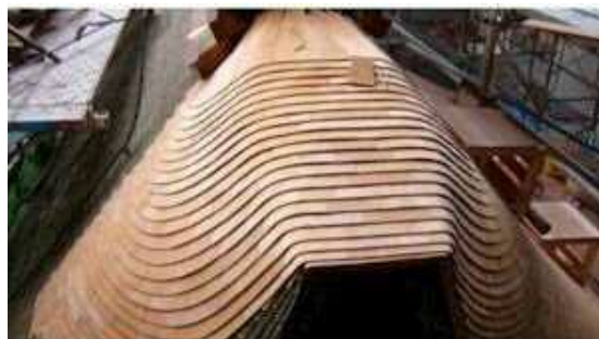
難しい棟の部分の葺き工事
