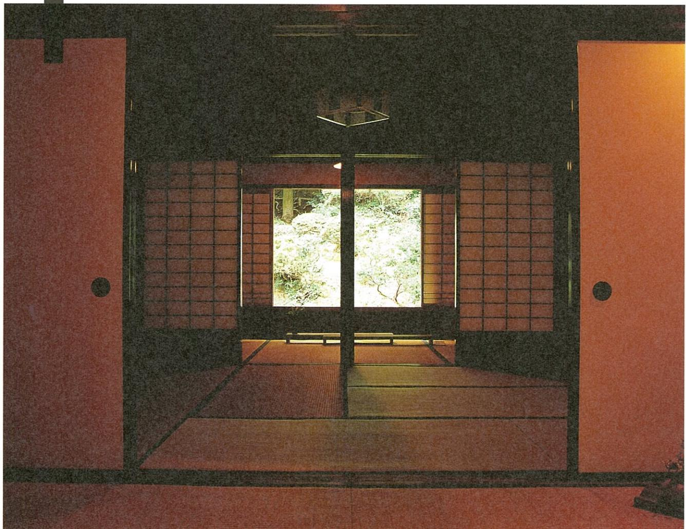
土間と接する茶の間は、太い柱にヒラモンと呼ばれる幅広い指鴨居や貫を通し、太い梁を十字に組んだ強固な「枠の内」構造となっている。上部は簀子天井で、意匠的な構造美を際立たせるように桁下には天窓が付く。
