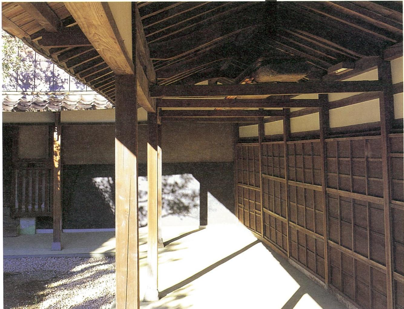
主屋から調度・衣装蔵への渡り廊下は、上部を漆喰壁、下部を無節の腰板張りとし、化粧屋根裏には梁や棟木を入れず、垂木だけで持たせた蒲鉾型(アーチ型)の珍しい意匠を用いている。
