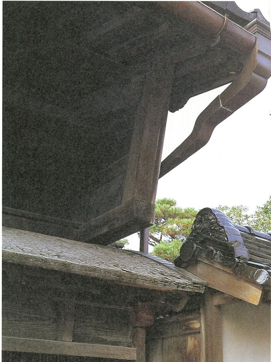
主屋左側の外壁は板張りで、オイ空間の採光と、小屋組構造を照らすために3つの天窓が付けられている。写真左には、張り出しの高欄が付いた2階縁側がある。正面に比べて簡素な意匠ながら、旧家の趣を感じさせる。
