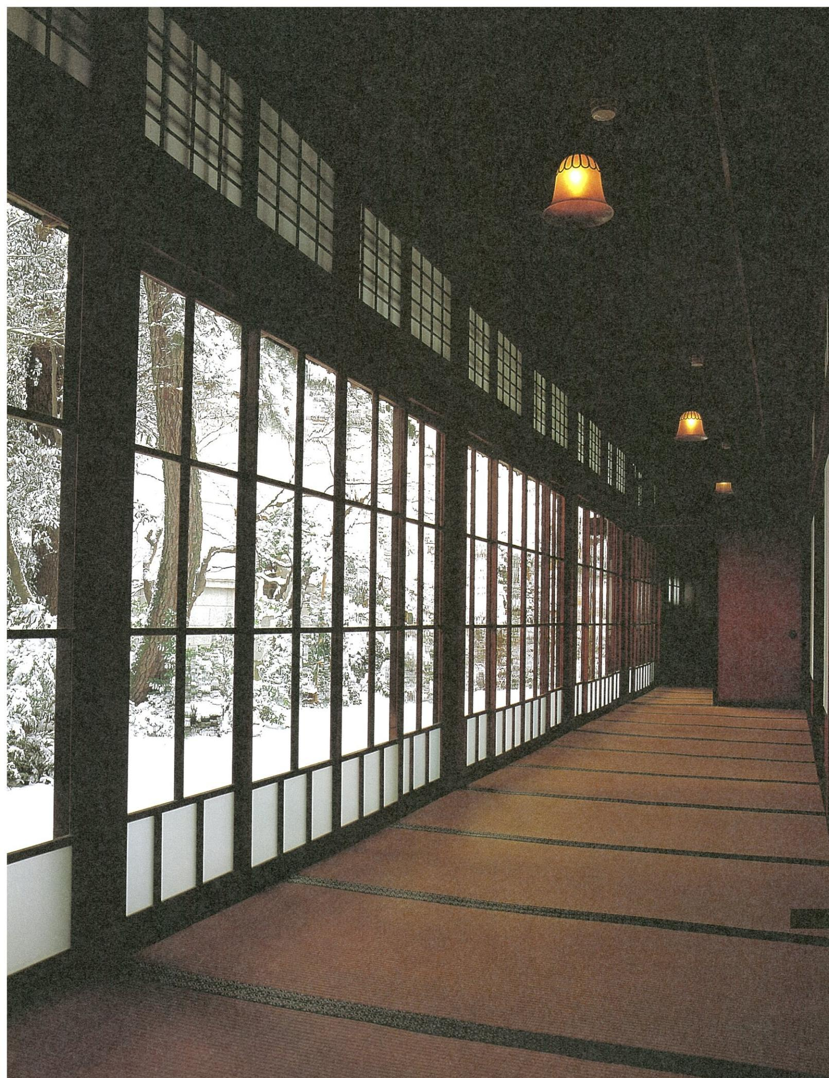
式台の左右(写真は右側)には6畳の部屋があり、その横には10畳の座敷(床の間)がある。式台は舞良戸で、他は狭間格子。客殿は銘木を多用し、床の間、天井、建具、土壁に至るまで贅を凝らしている。
