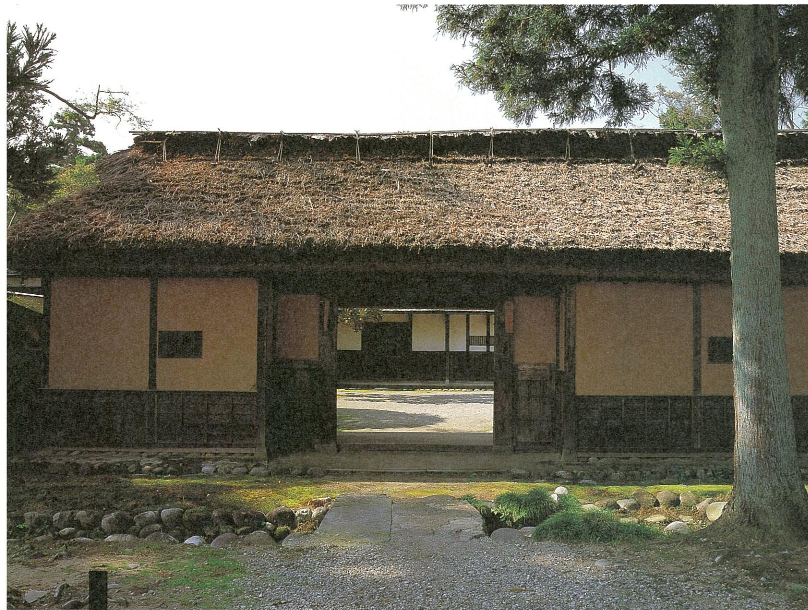
表門は桁行14mの入母屋造り・茅葺きの長屋門で、中央に扉口を開ける。扉左側の潜戸は敷鴨居に勾配を付けて、戸も菱形にした自動扉になっている。細かなところにも先人の知恵が見える。
