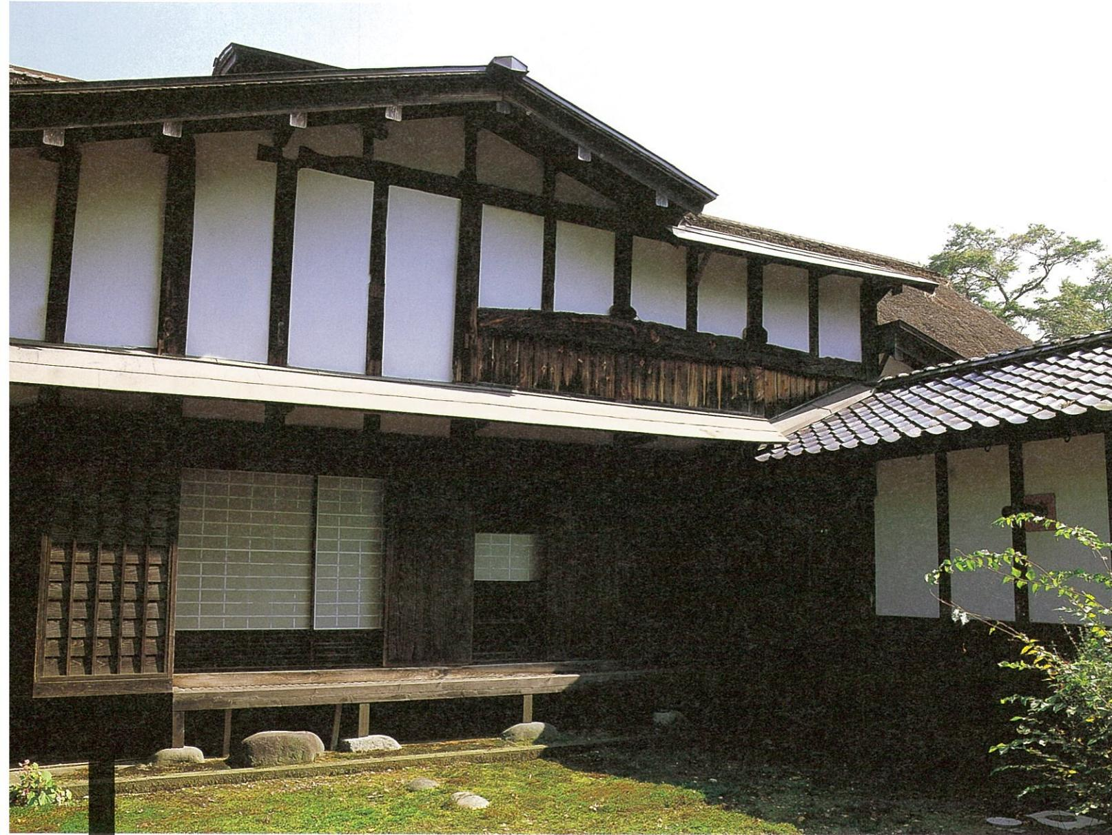
かつては、主屋と同規模の建物が写真の茶の間・台所棟を挟んでH型に建っていた。そのため、切り離された梁の木口などが外観に見えている。左の障子戸の内は台所、右は茶の間。
