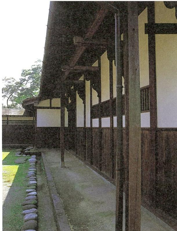
主屋の右側、土間と馬屋の正面には雁木状の下屋庇を出し、深い軒をつくり出している。半間の間隔で連続する柱や、出桁腕木が見せる構造美が印象的である。
