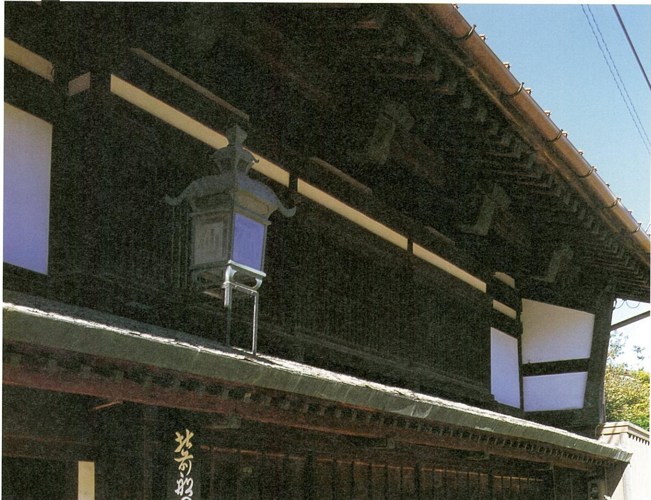
1階のスムシコ(簀虫籠)と2階の堅繁格子窓の意匠が外観を印象づける。また、むくりを付けたこけら葺きの庇が柔らかさを創出し、化粧銅板のアクセントとともに重厚な外観を軽やかにしている。
