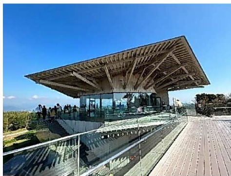
日本平夢テラス 外観
