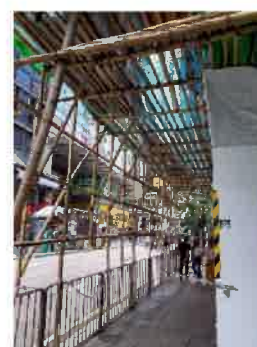
工事中の足場は竹製
