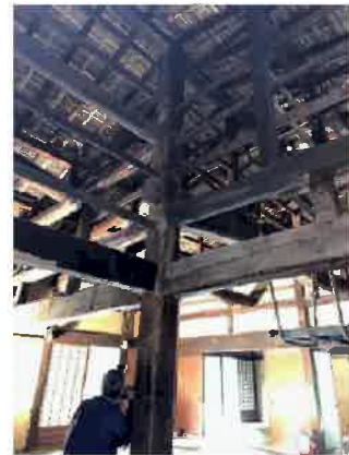
直接棟木を受ける シンボリックな棟持柱
